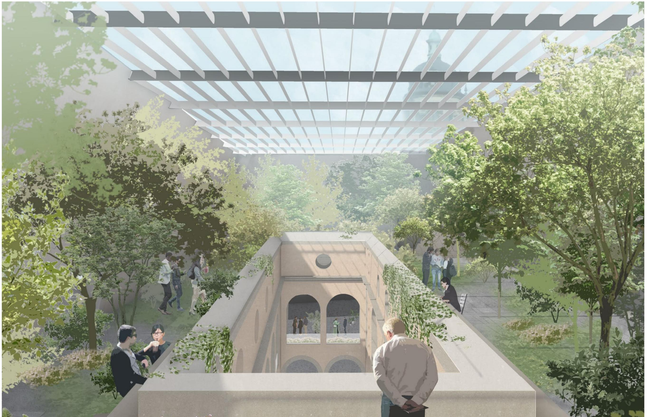
↑ Die Schließung des Innenhofs mit einer Neupositionierung des Glasdaches am Firstpunkt und die Umgestaltung des Dachgeschosses zu einer für die Mitarbeitenden nutzbaren Orangerie lässt inmitten der Dresdner Innenstadt ergänzend eine grüne Arbeitsumgebung entstehen
