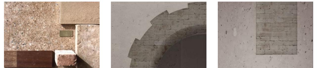
↑ Alle Eingriffen in die Bausubstanz wurden durch Wechsel von Texturen und Materialien sichtbar gemacht
